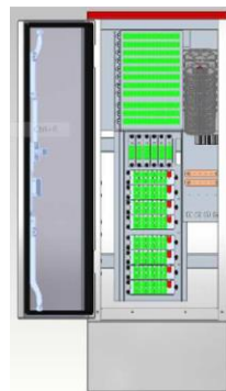
PUNTO DI TERMINAZIONE DI EDIFICIO (PTE) 24 U.I.
