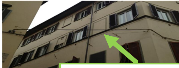
Cavo ottico in attraversamento
