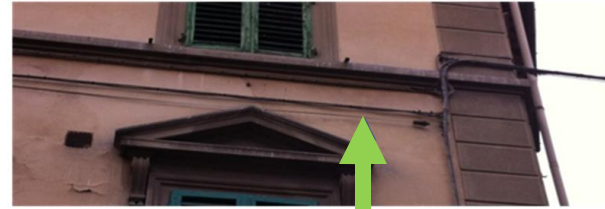
Cavo ottico in soluzione autoportante
